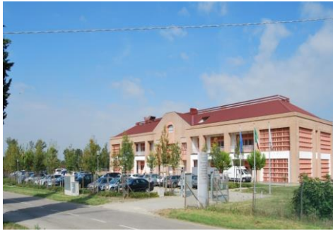
Edificio principale e laboratori
